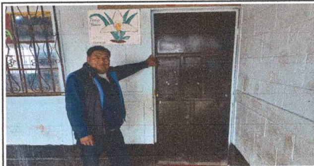
Foto 3: Sustitución de puerta 0.90 Mts. X 2.14 Mts.
