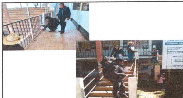
Foto 5: Sustitución de barandas de metal
