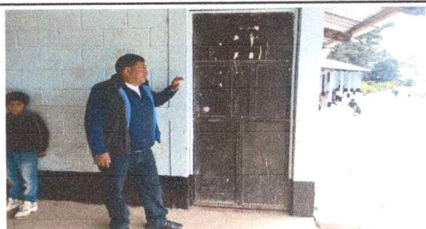
Foto 2: Sustitución de chapa
