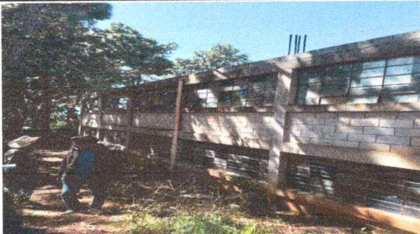
Foto 4: Sustitución de balcones de metal
