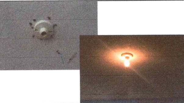
Foto 6: Sustitución de focos ahorradores y sustitución de plafoneras
